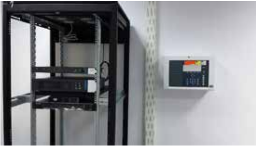
Haberleşme Sistemleri İle Fiber Optik Döşenmesi
