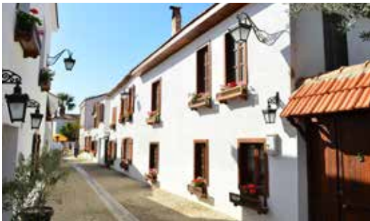
Sığacık Kale İçi Restorasyon Uygulaması
