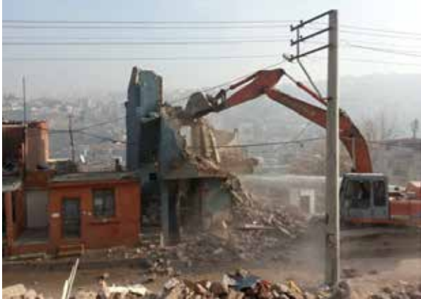
Yeşildere Heyelan Bölgesi'ndeki Yıkım Çalışmalarından Görünüm
