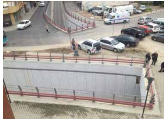
Akıncılar Karayolu Alt Geçidi
