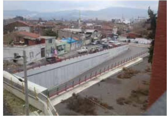
Akıncılar Karayolu Alt Geçidi
