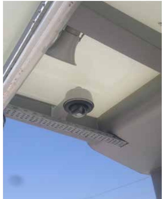
Haberleşme Sistemleri İle Fiber Optik Döşenmesi
