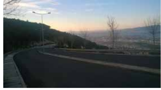
Toros Çamkule Bağlantı Yolu Çift Kat Harç Tipi Asfalt
