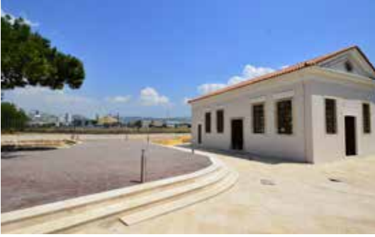
Doğanlar Şapeli Restorasyonu
