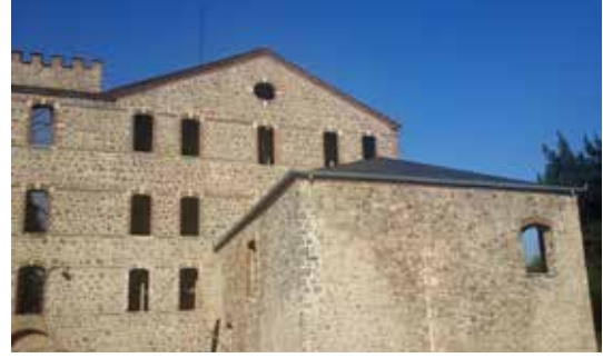
Tarihi Un Fabrikası Restorasyonu
