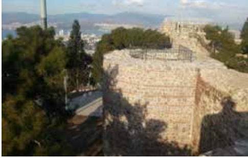
Kadifekale Sur Duvarları Restorasyonu
